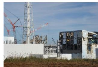
4 事故をおこした東京電力福島第一原子力発電所 (2011年) 地震と津波におそわれた原子力発電所では、電源が失われ原子炉が冷却できなくなり、1~3号機でメルトダウン (炉心溶融) がおきた。また、1・3・4号機の原子炉建屋は水素爆発で損壊し、大量の放射性物質が大気中に放出された。
