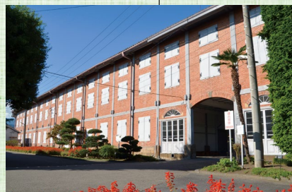
▲ 富岡製糸場と絹産業遺産群 (富岡製糸場東蔵倉庫)
